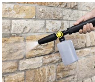
Защитное импрегнирование фасадов, кирпичных и каменных стен.
